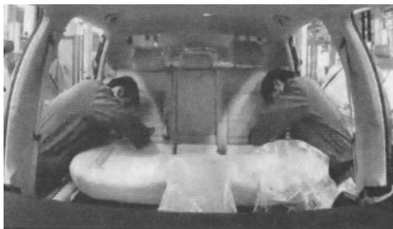
图 5-58 安装后排座椅
